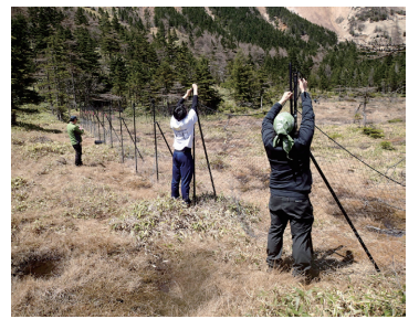
雪解け後に防鹿柵のネットを再設置している様子
