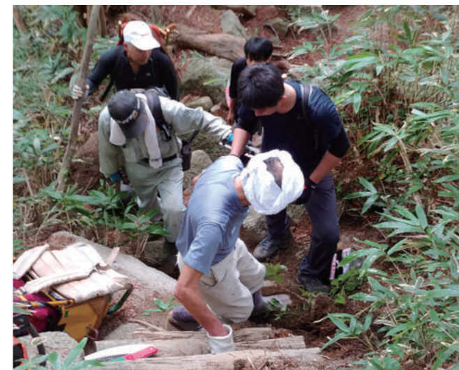
協力して木製階段の修繕作業を行う
