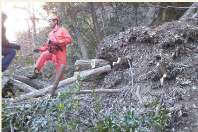
土砂崩れによって崩壊した道を整備する隊員たち
