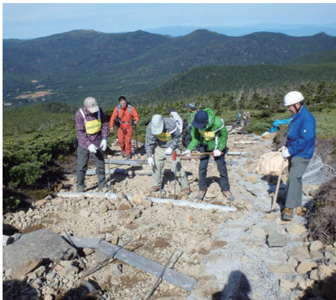
階段状に丸太を設置して土砂止めをつくる
